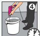
**4** При ручном нанесении для подготовки раствора залейте водопроводную воду комнатной температуры в чистую ёмкость из расчёта 10,5-11,5 л воды на 1 мешок (30 кг). Перемешайте раствор дрелью со специальной насадкой на низких оборотах, засыпая сухую смесь в воду до получения однородной массы. Подождите 5 минут, после этого перемешайте вторично. Время пригодности раствора к работе не менее 2 часов.
